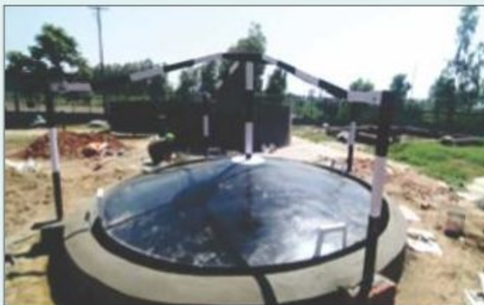
Placing M. S. Gas holder
